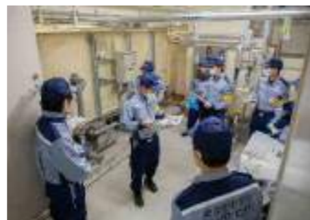
【受水槽の確認】
