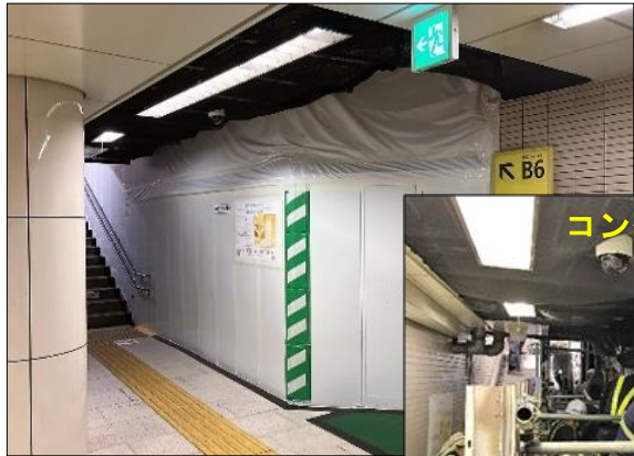
写真1 資材投入立坑のH鋼杭建込みのための掘削作業(夜間)
