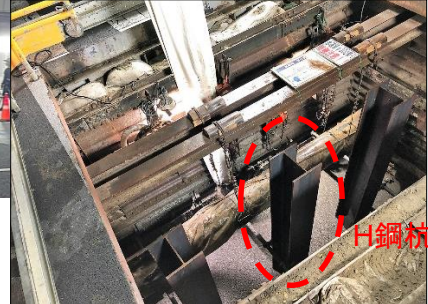
写真1 資材投入立坑のH鋼杭建込みのための掘削作業(夜間)
