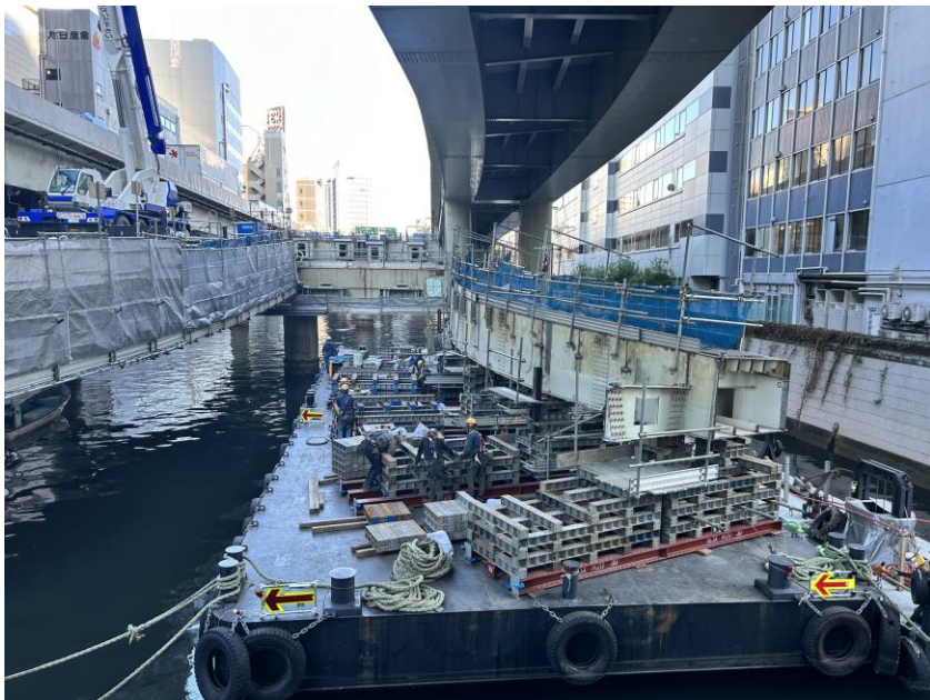
呉服橋入口の橋げた撤去状況
