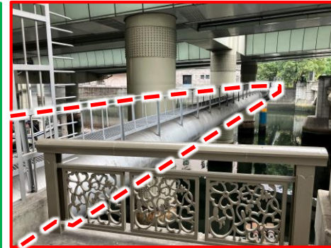
④既設水道管
