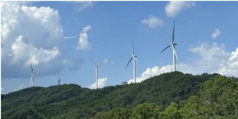
阿武隈風力発電所の風力発電設備
