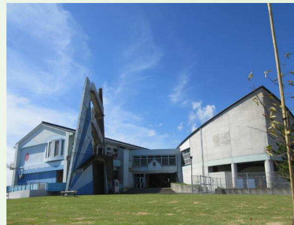
震災遺構・請戸小学校
