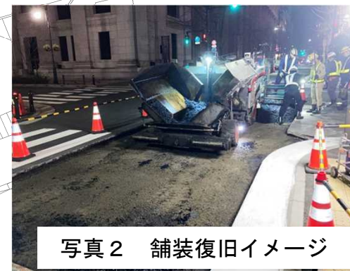
覆工板撤去後 舗装復旧範囲
