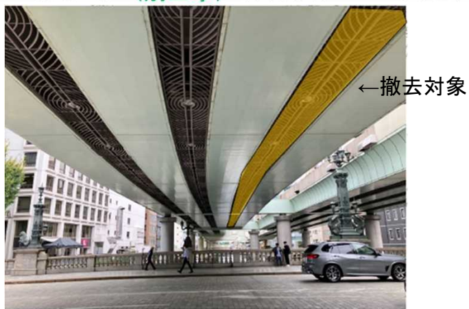
写真1 日本橋上空（4月から桁下デザイン板を撤去） ※夜間交通規制を行います。
