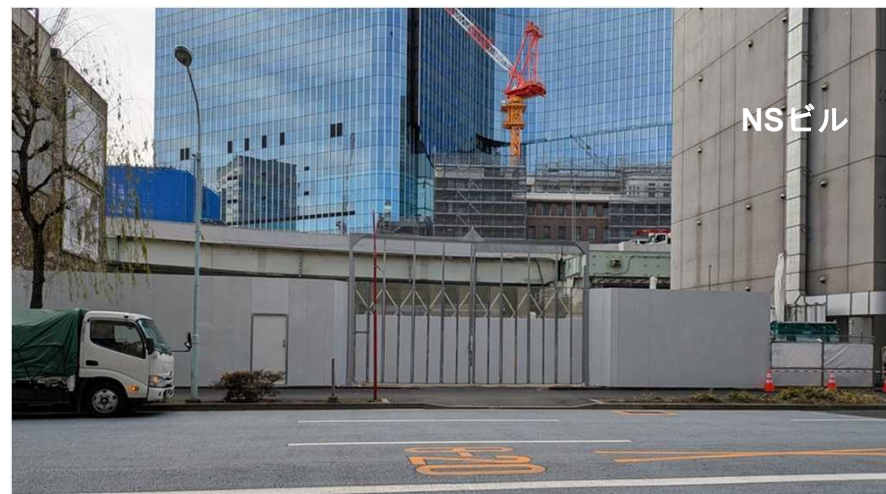
写真2 室町一丁目（タイムズ及び寿司貞跡地） 仮囲い設置状況
