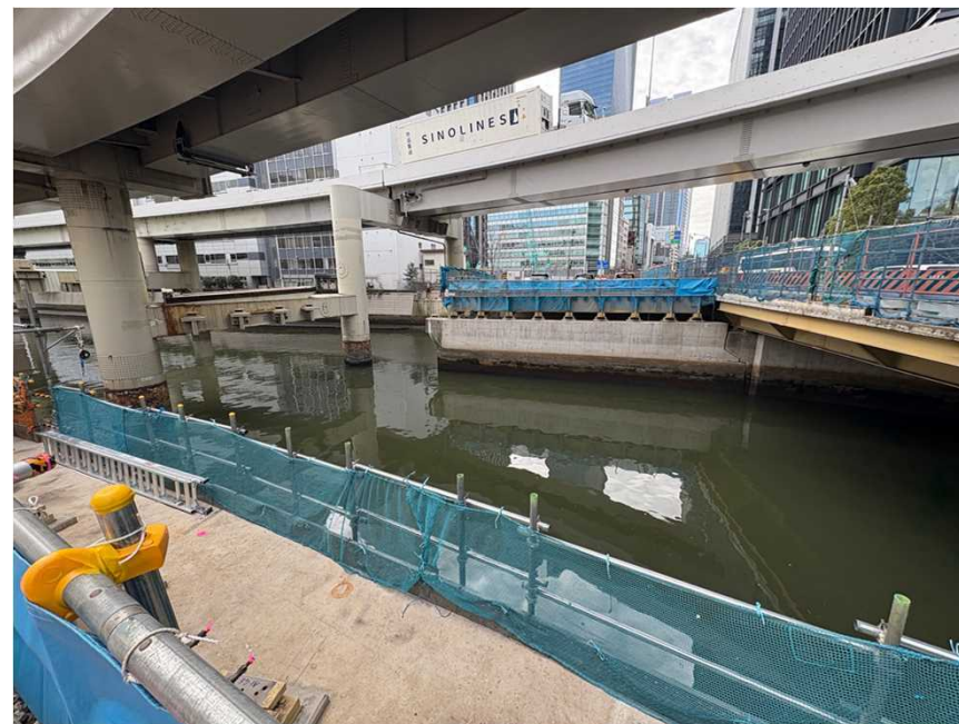
写真1 一石橋北側撤去状況
