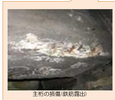
主桁の損傷（鉄筋露出）
