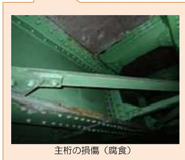
主桁の損傷（腐食）
