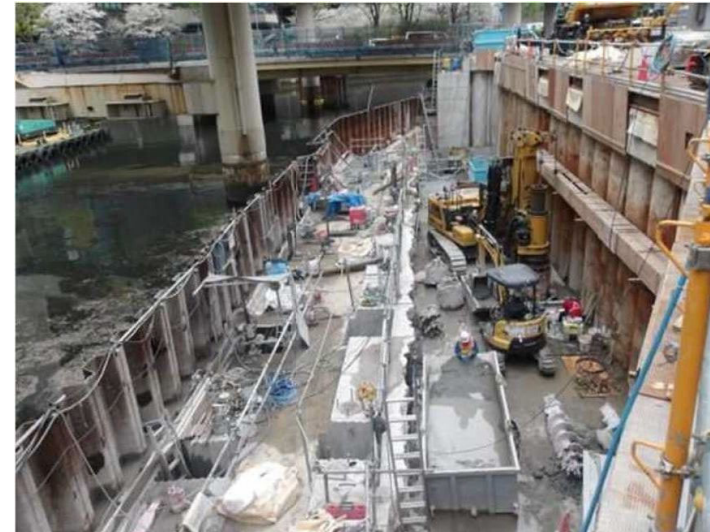
写真1 既設構造物撤去状況
