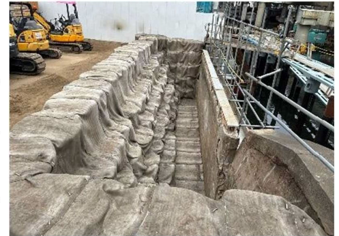
写真1 橋台の補修状況
