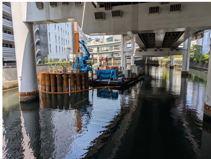
写真1 基礎杭施工状況（鎧橋上流・右岸）
