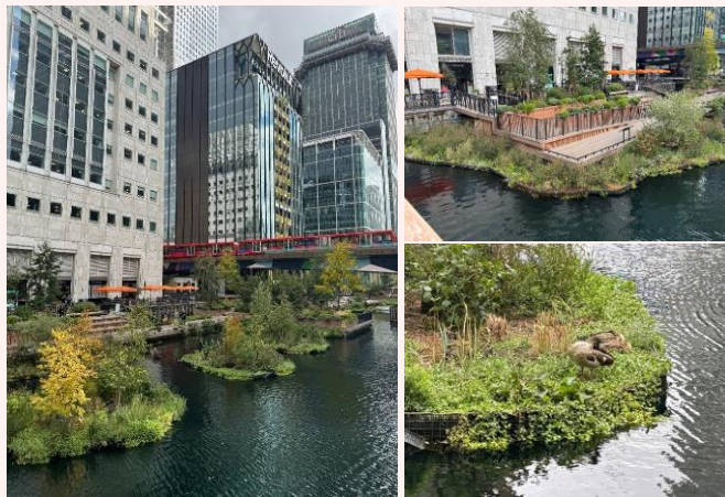
写真 ロンドンでの浮島の取組 Eden Dock（清水建設（株）提供）
