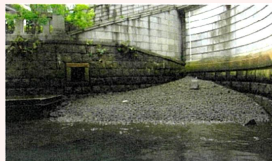
写真 石炭灰造粒物の施工イメージ
