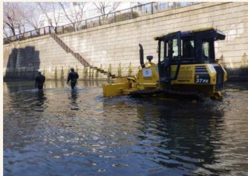
写真 河床整正（目黒川例）
