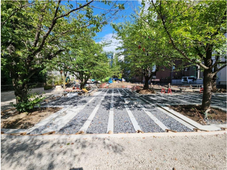
【写真2】ウッドデッキ基礎の施工状況
