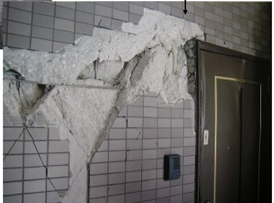
雑壁が破損し、住戸内が覗ける
