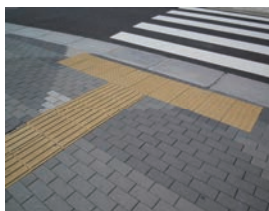
点字ブロック（点字ブロック）
