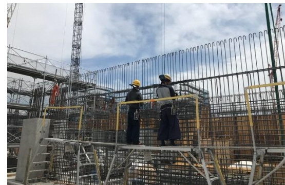
5-5 街区 地上躯体の整備状況(鉄筋組立)
