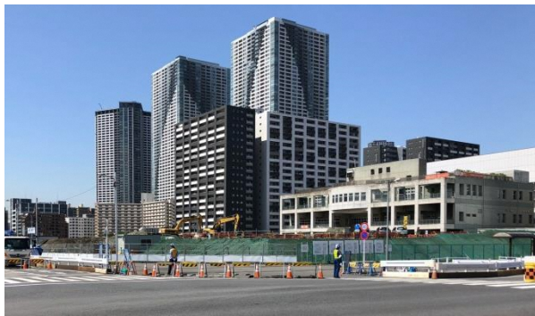
5-7 街区 工事着手前の状況
