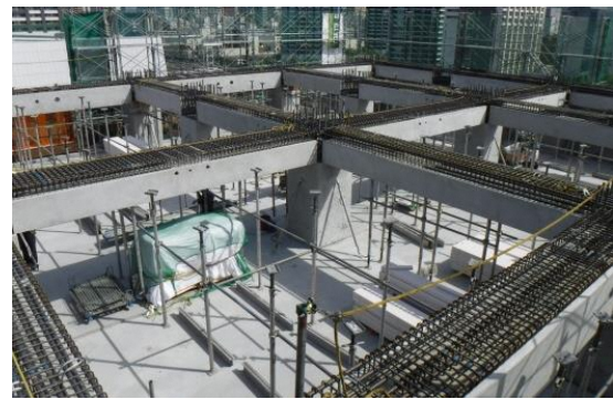
5-3 街区 地上躯体の整備状況(上空から)
