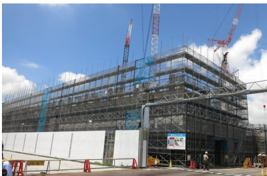
5-5 街区 地上躯体の整備状況(地上から)
