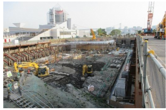
5-6 街区 地下の掘削状況（近方から）
