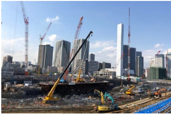
5-6 街区 地下の掘削状況（遠方から）
