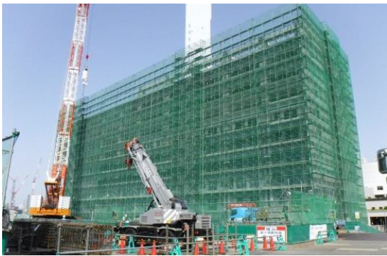
5-3 街区 地上躯体の整備状況(地上から)
