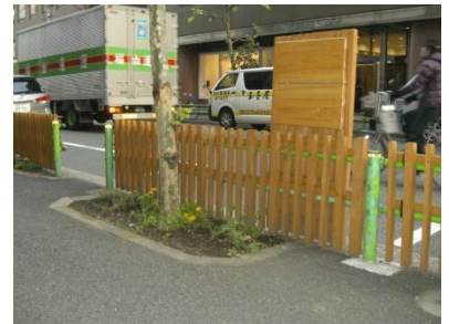
木製横断防止柵（中央区）
