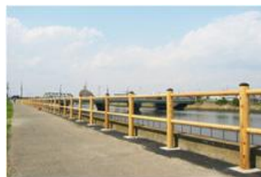
河川沿いの転落防止柵 （江東区～葛飾区）
