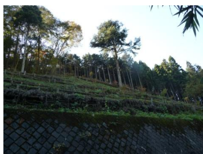
皆伐されモミジが植栽された斜面
