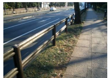
多摩産材活用木製ガードレール （千代田区英国大使館前）
