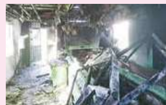
リチウムイオン電池の発火が原因で、リサイクル工場の建屋・設備が焼けてしまった事例（出典：公益財団法人日本容器包装リサイクル協会）
