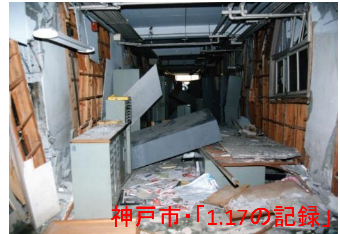
家具・設備機器などの転倒・落下 (1995年兵庫県南部地震)
