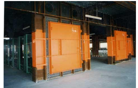
制震補強の例
