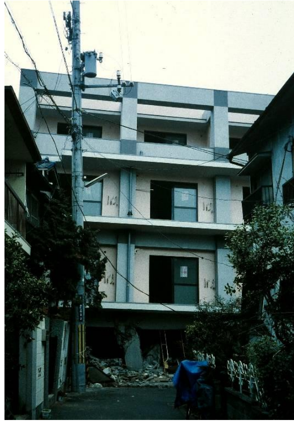
新耐震基準の建物被害はピロティーなど
