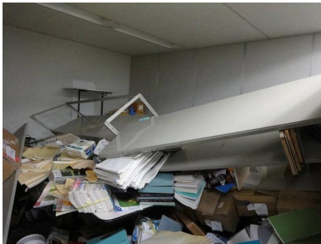
24F(本棚の転倒、間仕切り壁の大変形)
