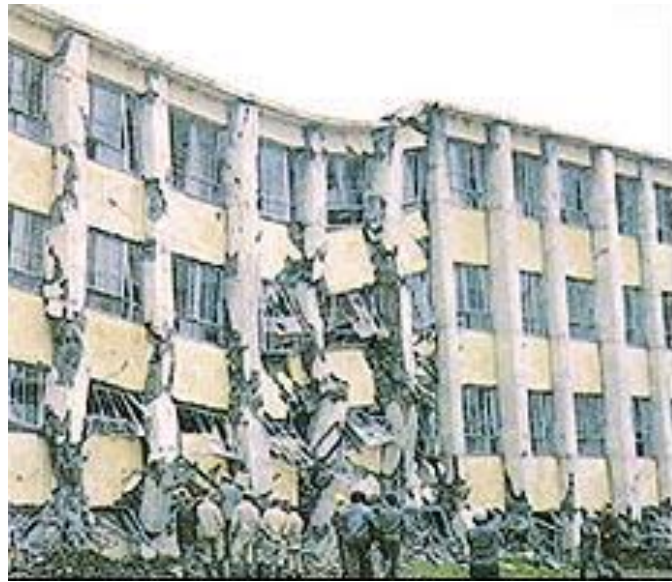
1968年十勝沖地震 (RC造短柱被害など)
