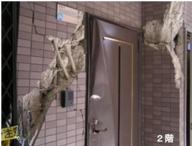
非構造壁の被害 (2005年福岡県 西方沖地震)
