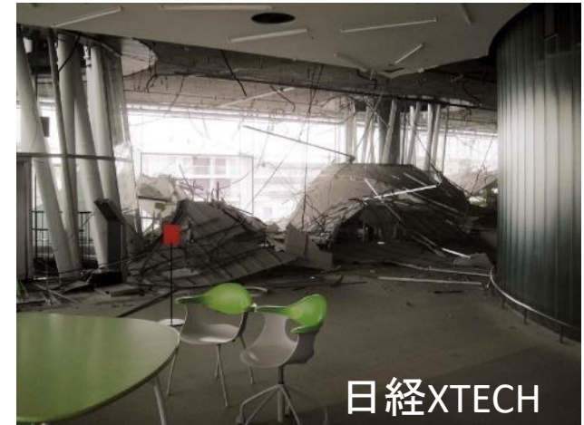
天井・外装材などの落下 (2011年東北地方太平洋沖地震)
