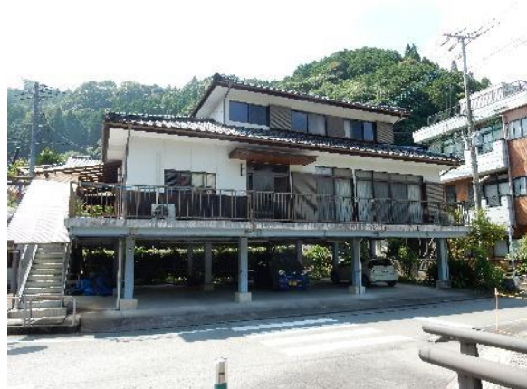
2022年球磨川水害で浸水被害を逃れた混構造(S+木)住宅(球磨村・一勝地)
