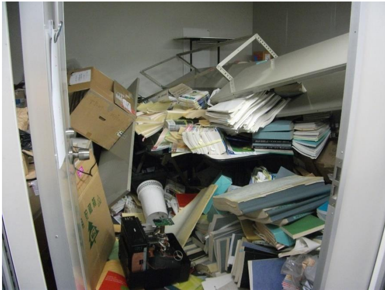
東日本大震災における新宿の超高層ビル 24階の本棚転倒と間仕切り壁の変形
